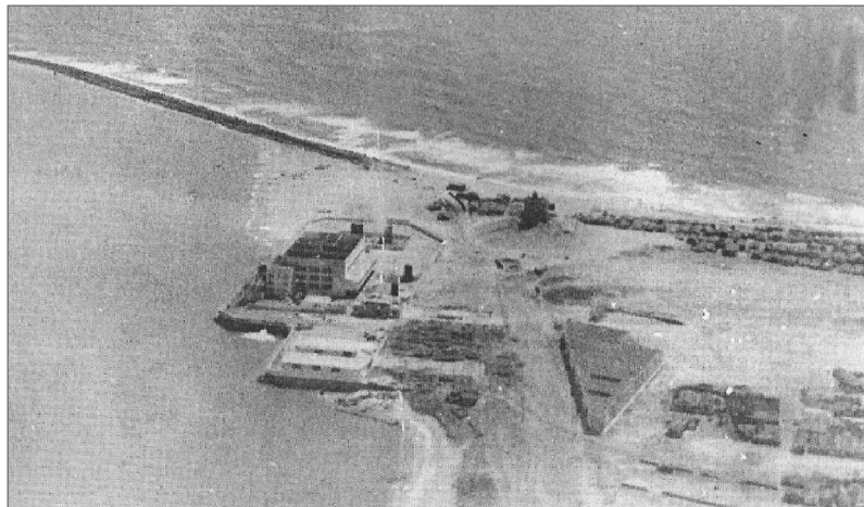
Figura 3 Vista Aérea da Usina do Mucuripe (SERVILUZ), na antiga praia Mansa, próximo ao Farol, em 1955.
