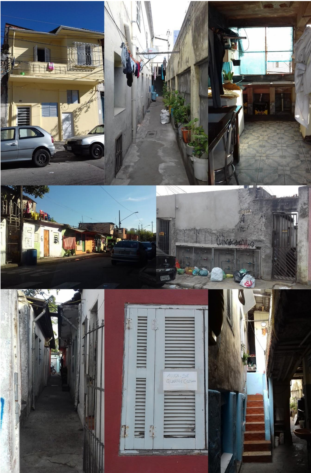
fig.05 | painel de fotos de moradias precárias levantadas
