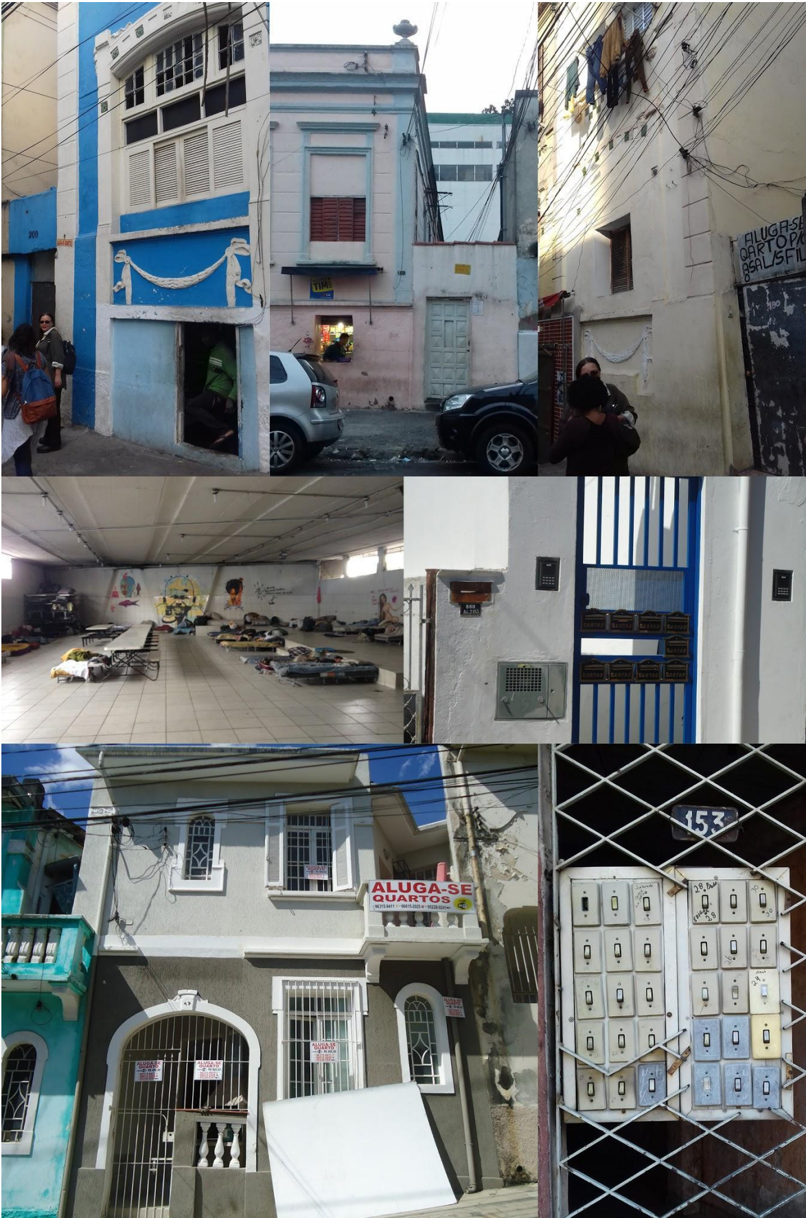
fig.03 | painel de fotos de moradias precárias levantadas
