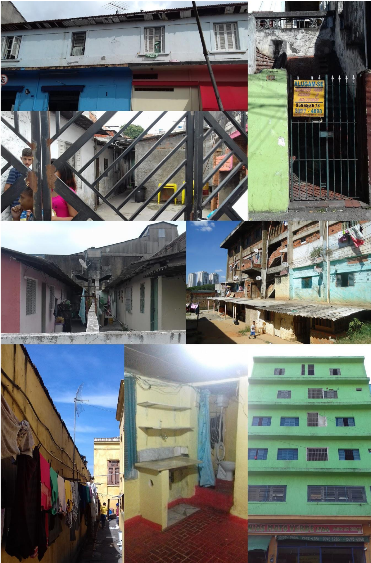
fig.04 | painel de fotos de moradias precárias levantadas
