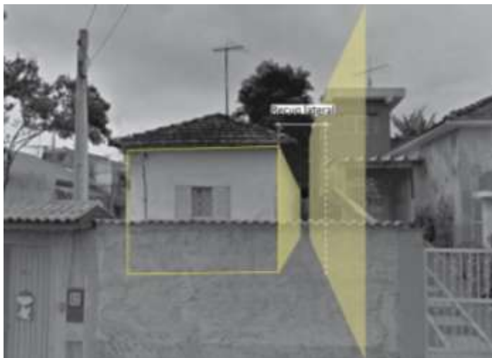
Figura 7: Recuo lateral de uma moradia em um bairro residencial horizontal de Ferraz de Vasconcelos. A distância entre a casa e a divisa lateral do lote é resguardada mesmo, quando não há cômodos voltados para o recuo. Fonte:elaboração própria
