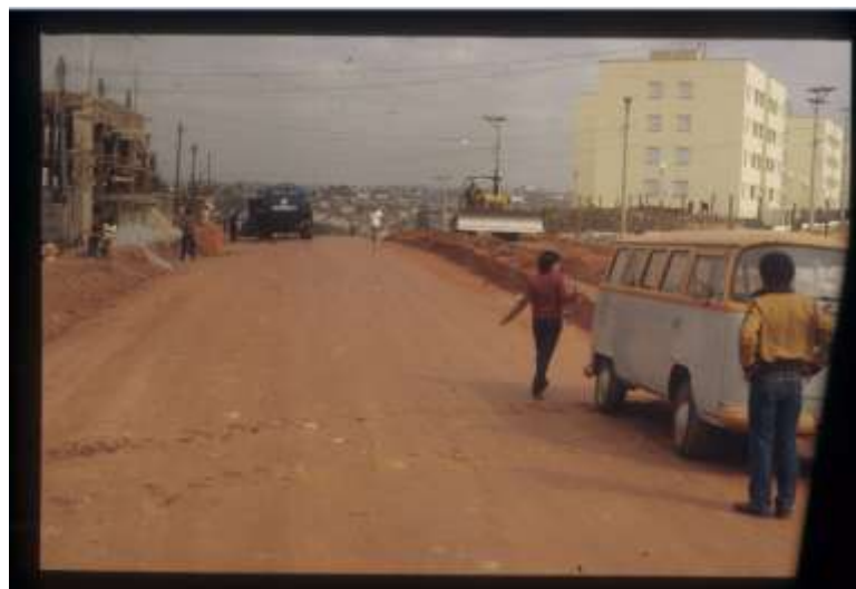
Rebaixamento da Av. Mal. Edgar de Oliveira durante o Projeto Mutirão (Créditos: Raul Pereira)
