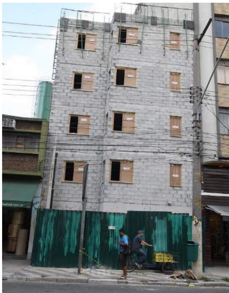
Figura 18 • Obras no terreno da Rua São Caetano, 1110. Fonte: Folha de São Paulo. Disponível em < http://www1.folha.uol.com.br/cotidiano/2016/04/1764286-plano-de-alckmin-para-construcao-de-moradia-no-centro-de-sp-falha.shtml >
